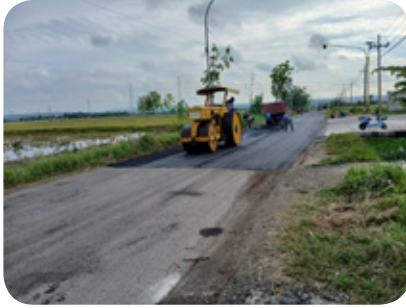
Perbaikan jalan Road Repair
